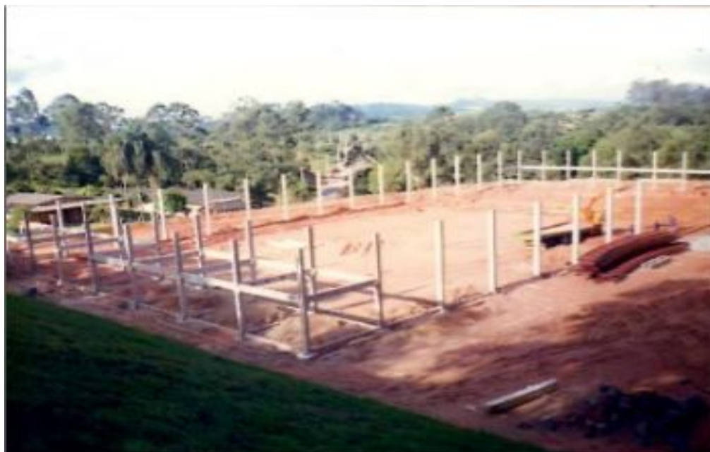
Figura 1 - Início das Obras Sede Própria
