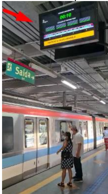
Figure 15 - "Próximo Trem" platform monitor
