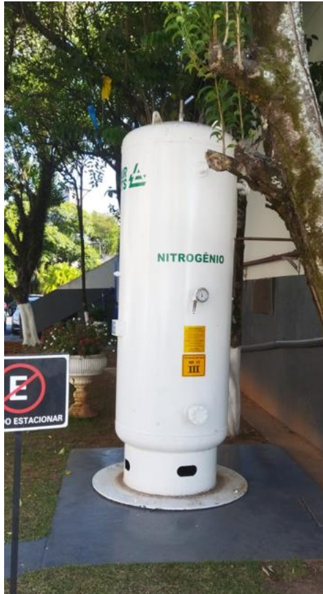
Figura 4 – Visita Empresa 2 (estrutura de manutenção)
