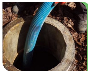
Foto 28: Inspeção de fossa
