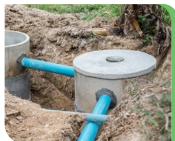
Foto 27: Instalação de fossa séptica
