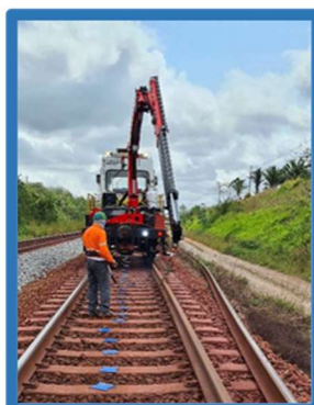
Substituição de Trilhos Longos Soldados
