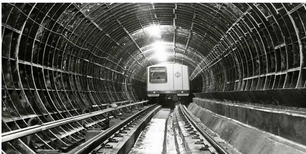
Figura 9 – Composição do Metrô no Trecho em Shield entre Praça da Sé e Luz da Linha 1 – Azul
