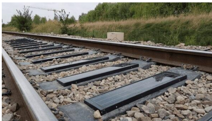
Figura 9 - Dormentes com mistura plástica e painéis fotovoltaicos incorporados
