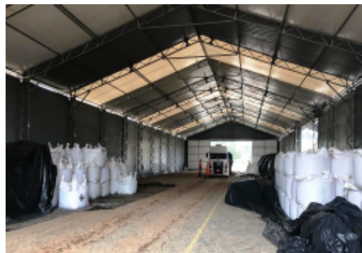
Figura 6 – Galpão para cargas unitizadas e trabalho de handling ferroviário de container
