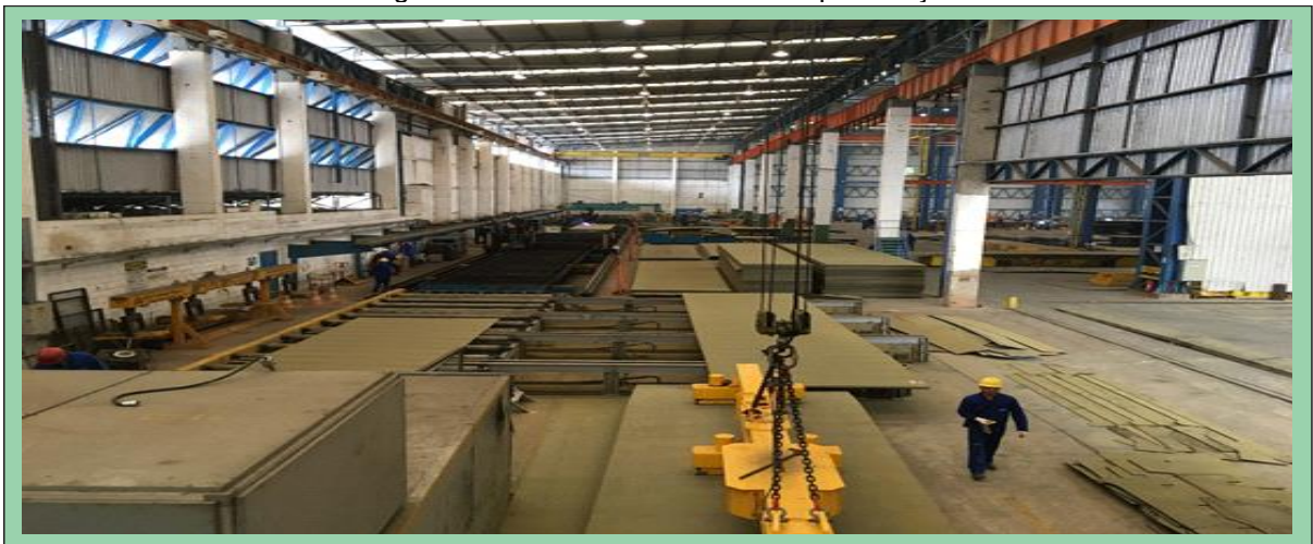
Figura 11 - Posicionamento de chapa de aço
