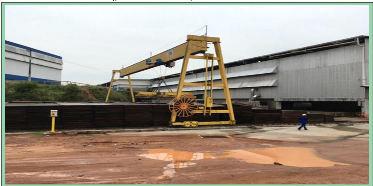
Figura 9 - Estrutura do pórtico do BECONAL
