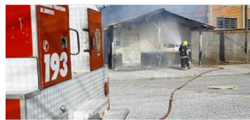
Prevenção e combate a incêndio
