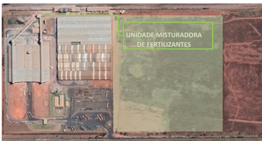
Figura 16- Localização da unidade misturadora, alimentada pela correia transportadora, direto da ferrovia
