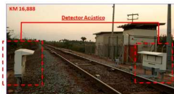
Figura 50 – Medidores de acústico wayside EFC
