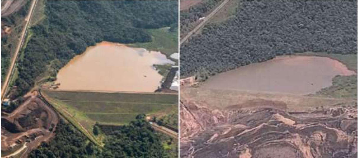
Figura 24 - Imagem a esquerda mostra a barragem antes do rompimento; à direita, a barragem após o incidente
