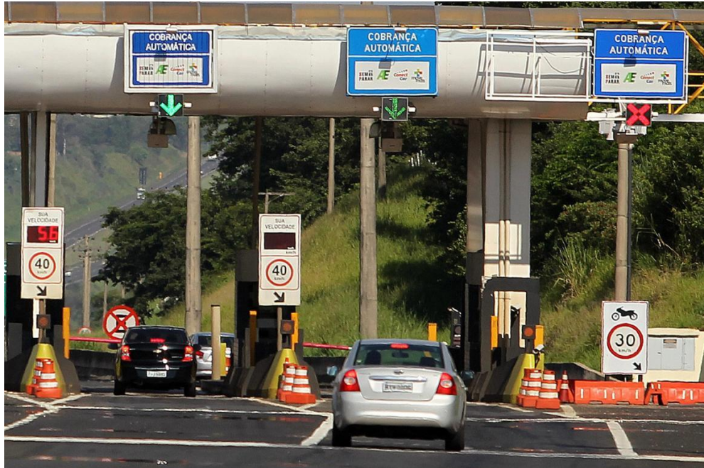
Figura 9 – Cabine de Passagem de Pedágio com Cobrança Automática
