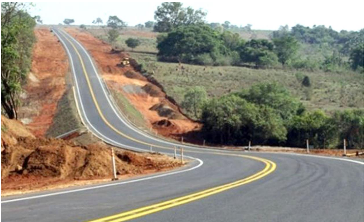
Figura 7 – Manutenção de 60 km na Rodovia MT-235
