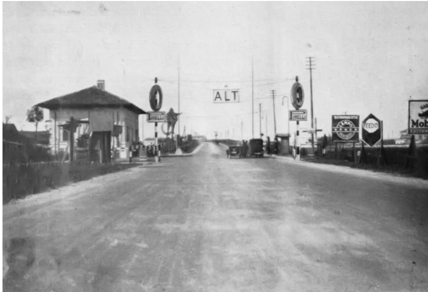
Figura 2 – Autoestrada de Laghi – 1929
