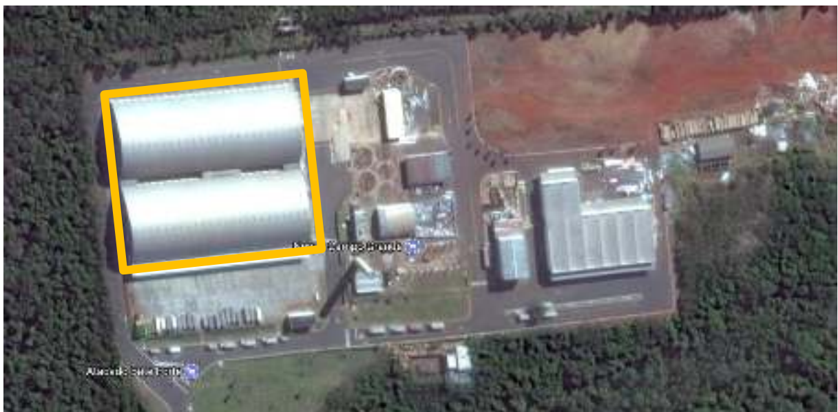
Figura 6 - Visão aérea do armazém visitado
