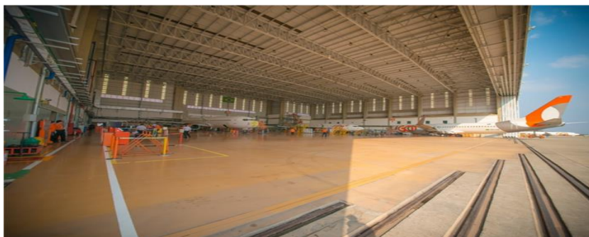
Figura 22. Centro de Manutenção (CMA) – CONFINS – MG
