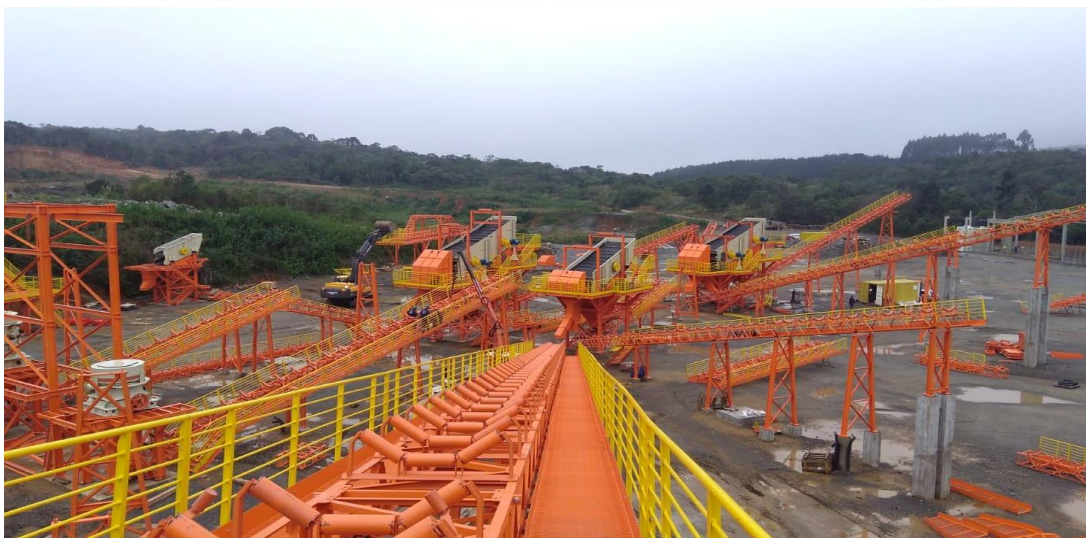
Figura 10 – Reestruturação da britagem
