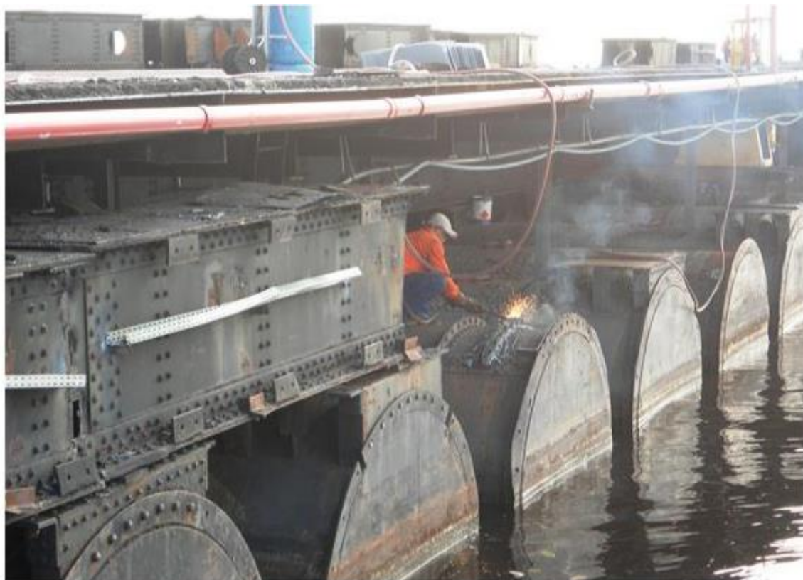
Figura 14 - Reparo no cais flutuante Fonte: (Porto de Manaus, 2019)
