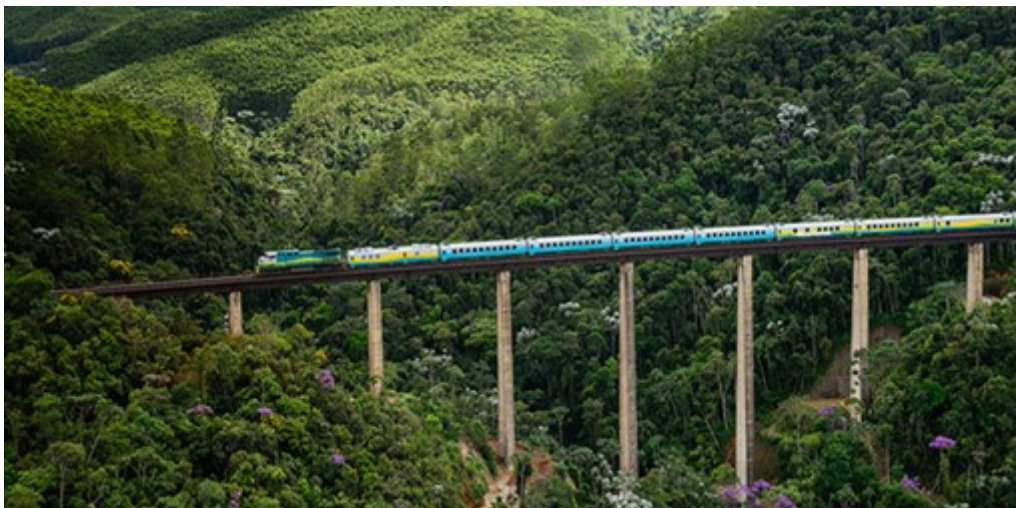
Figura 5- Estrada de Ferro Vitória a Minas
