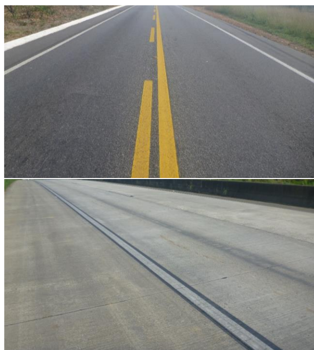
Figura 1: Pavimento flexível (acima) e pavimento rígido (abaixo)
