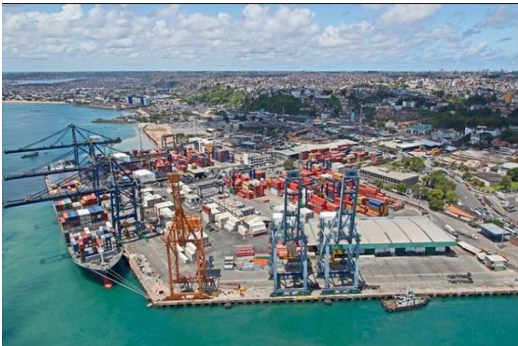
Figura 9 – Tecon Porto de Salvador – Vista aérea
